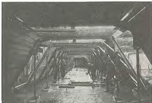
Fig. 6. Arbejdskammer i en trykluftcaisson støbt i dok.
