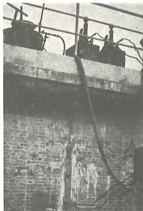
Fig. 17. Kemikalieinjektion i revnet murværk. Øverst t. h. i billedet står 2 håndpumper hvorfra de tynde trykrør fører til det indstøbte injektionsrør nederst i billedet.
