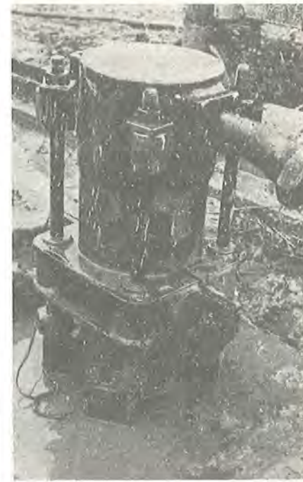
Fig. 25. M.V.-pæl. Rammehovede med ledning for cement-mørtel
