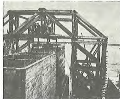
Fig. 30. Flydekran med sænkekasse.
