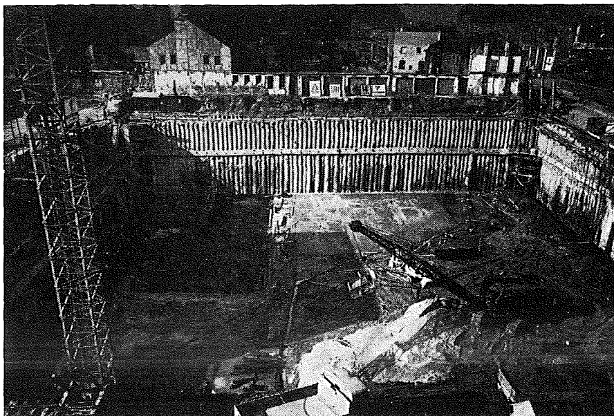
Fig. 18. Færdig Benoto-væg.
