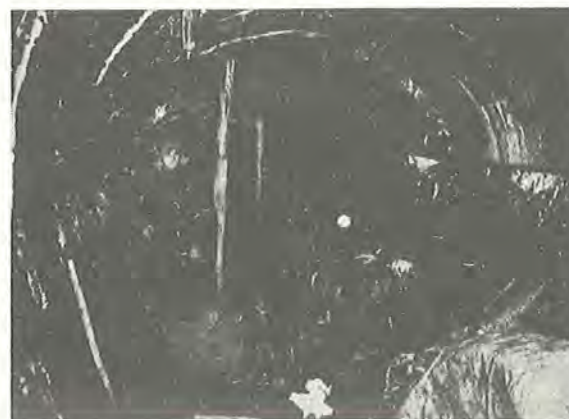
Fig. 19. Cementinjektion (1 pumpe) ved et tunnelarbejde, bemærk vandstrålerne fra tunnelloftet, (kloaktunnel under Øresund).
