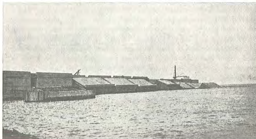
Fig. 16. Støbning af sænkekasser.
