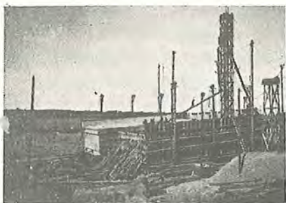
Fig. 13. Støbning af sænkekasse, Memel.
