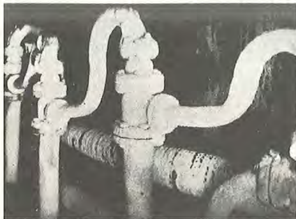
Fig. 24. Cirkulationsledning for frysning i borerør.
