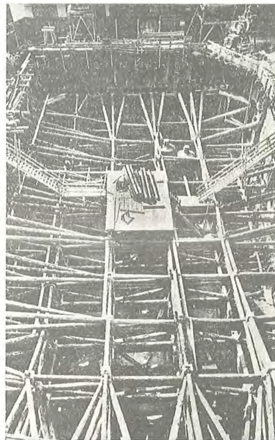
Fig. 11. Indvendigt afstivet byggegrube.
